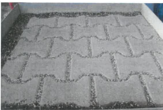
Bild 3: Im Testmodell eingebautes DT-Drain-Pflasters
