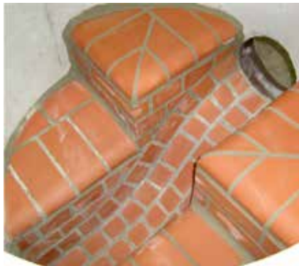
Schachtunterteile mit Rinne und Berme aus Kanalklinker
